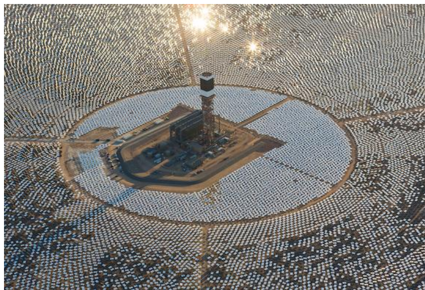
Solar Electric Generating System in California nel deserto di Mojave vicino al confine con il Nevada
