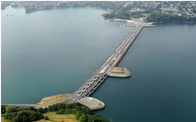
Veduta aerea sulla centrale mareomotrice alla foce del fiume Rance (Francia)
